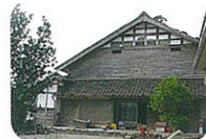
旧家屋/砺波市野村島地内 居宅/木造瓦葺平屋建
